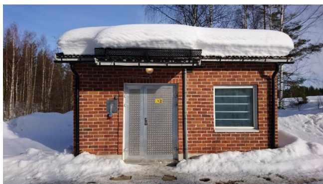
Figur 1. Bild på vattenverket i Niemisel.
