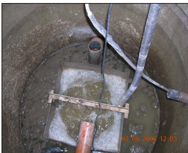
Figur 19. Bioreaktorn i BAGA minireningsverk.
