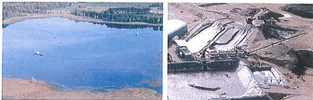
Figur 4 Muddring med sugmudderverk (till vänster) med efterföljande avvattning och vattenrening (till höger).
