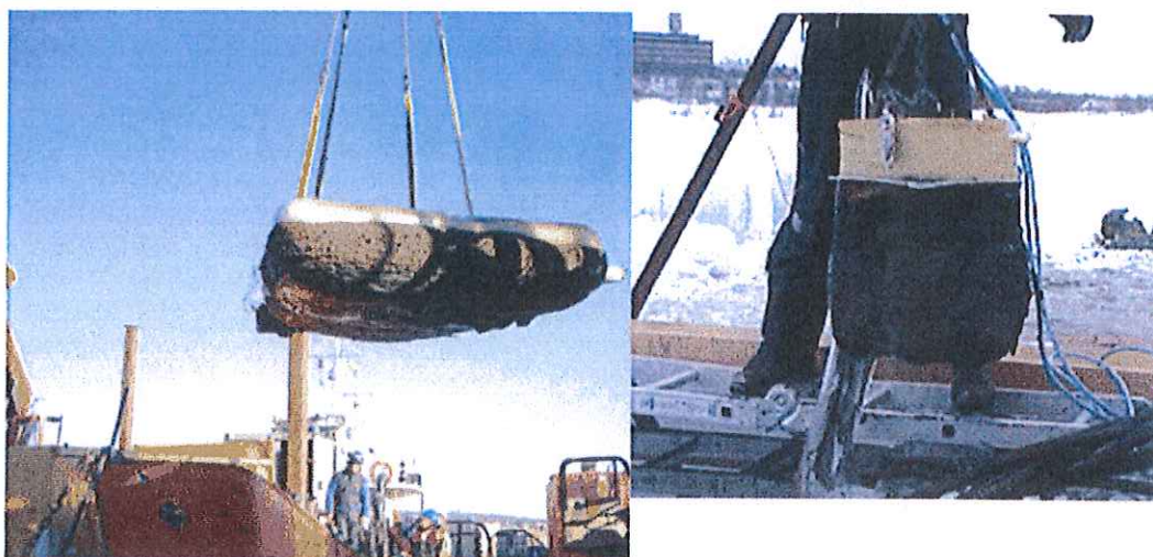
Figur 2 Frysmuddring med varierande utformning av frysaggregat, beroende på önskade muddringsdjup
