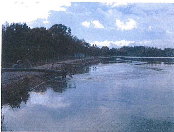
Figur 6 Avvattning genom enkel sedimentering i bassäng
