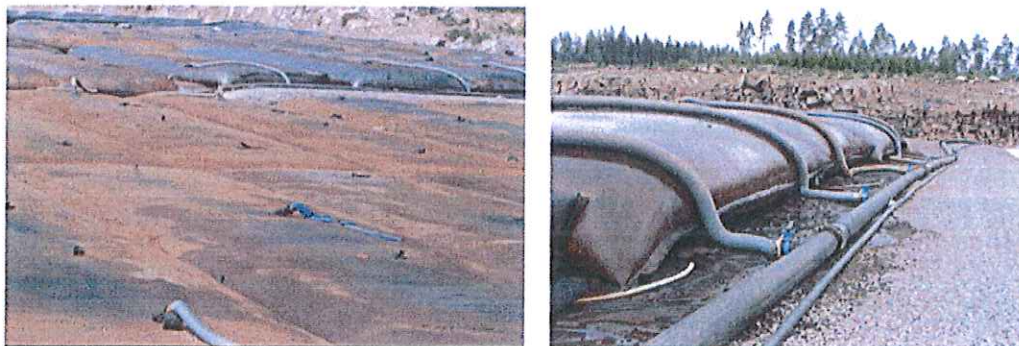
Figur 5 Avvattning i geotuber
