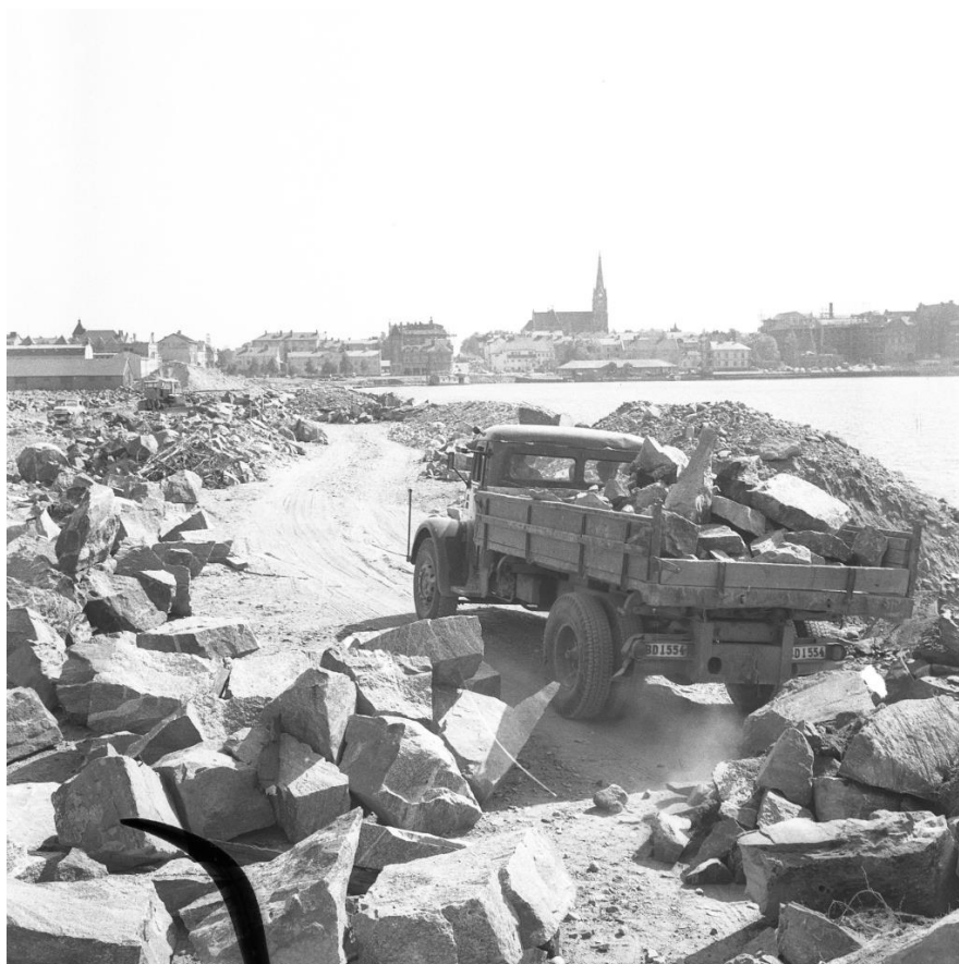
Nya Boden vägen. Nya Boden vägen kallas den rygg av stenmassa som sträcker sig över stadsviken i Luleå. Det är början till nya infarten till staden, ett byggnadsprojekt som kommer att kosta 6,5 miljoner i färdigt skick. Därmed försvinner en besvärlig flaskhals. Fyllnadsarbetena på den nya infarten pågår mest nattetid. Detta på grund av svårigheterna att få tag på lastbilar för dagstransporter. Dygnet-runt-arbetena medför att vägarbetet går ytterst snabbt. Publicerat i NK 19610613. Stadsarkivet
