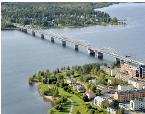
Bergnälsbron är en av utrymningsvägarna söderut.
