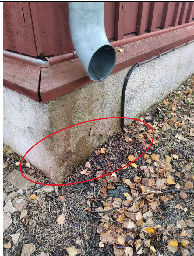
Bild 3. Sockelskador
