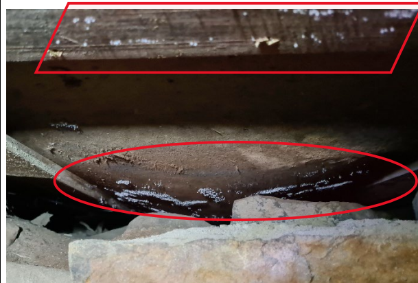
Bild 15-16. Mikrobiell påväxt på trossbottensskivor i matkällare.
