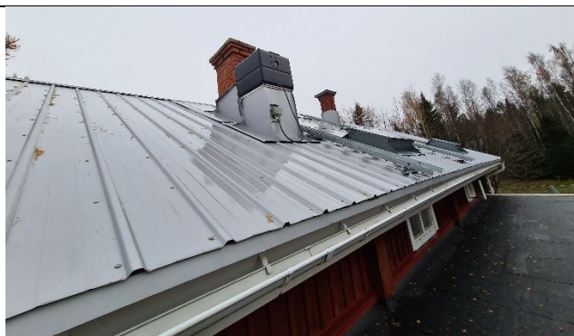
Bild 11: Papptak på utbyggnad, luftat parallelltak ovan veranda
