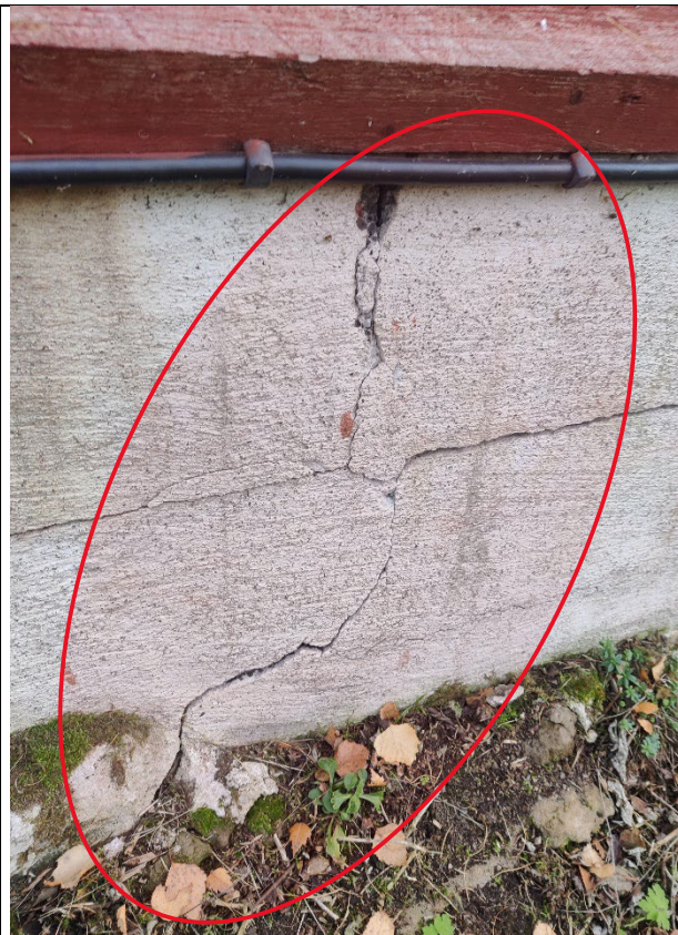
Bild 4. Sockelskador
