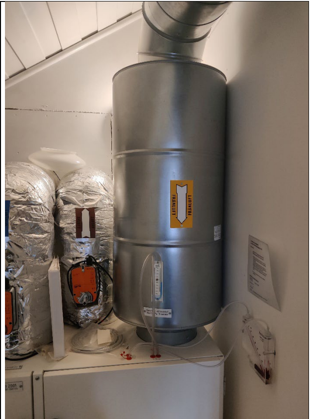
Bild 30. FTX, fläktaggregat
