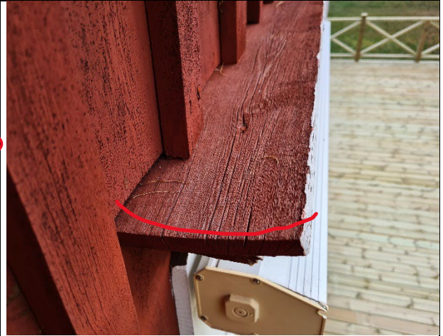
Bild 4: Vinkelfe/skålade träöverstycken.
