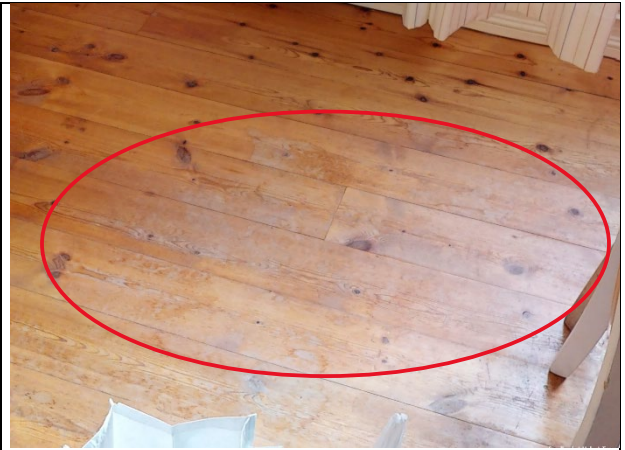
Bild 24. Slitage golv Matrum
