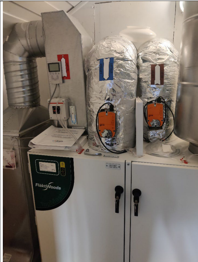
Bild 29. FTX, fläktaggregat
