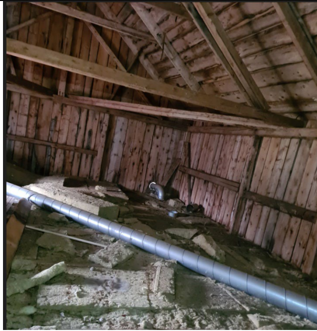
Bild Kallvind ovan bastu
