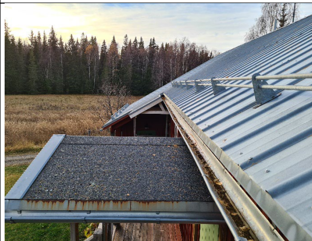
Bild 10: Plåttak och papptak. Takavvattning behöver översyn/service.
