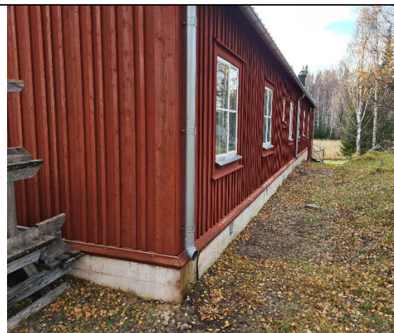
Bild 2. Fasad och sockel
