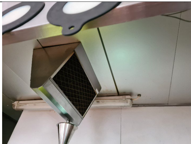
Bild 32: Storköksutrustning, fettfilter
