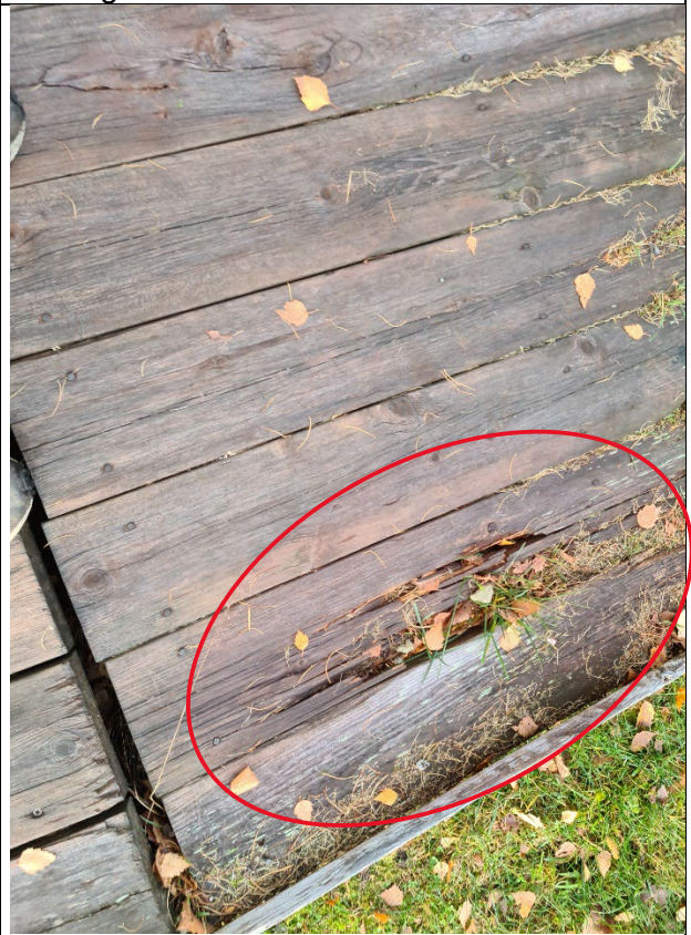
Bild 14. Altan, rötskador
