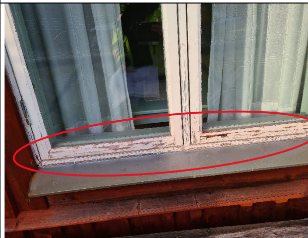
Bild 4. Sockelskador
