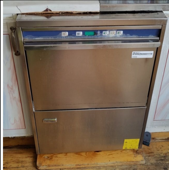
Bild 35: Storköksutrustning, diskmaskin i underskåp. Fuktanvisning i bänkskiva
