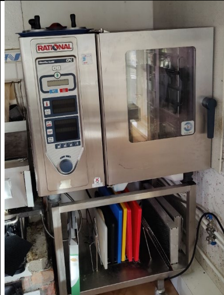
Bild 34: Storköksutrustning, ugn under köskåpa
