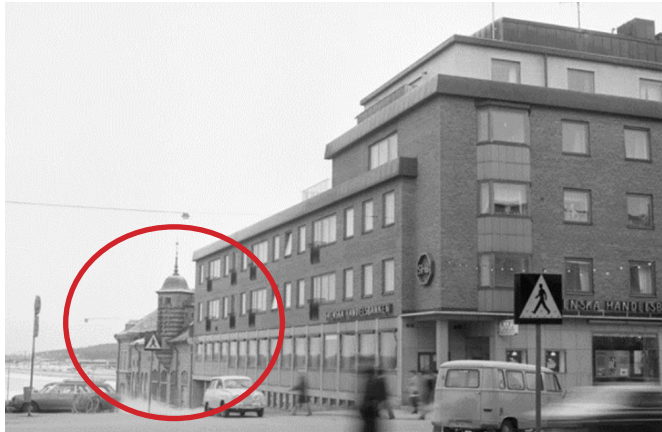
Figur 5 Bild från 1971 inför rivning av elverket längst ner på Nygatan.
